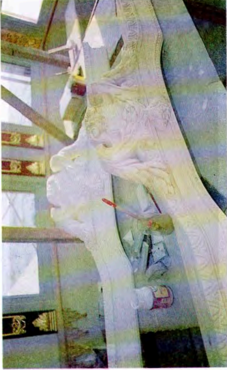
Asaf paşa yalısı, Deniz Köşkü'nün antik altın varak ile yapılan Kornişlerin bolonya alçısı ile kaplanması.
