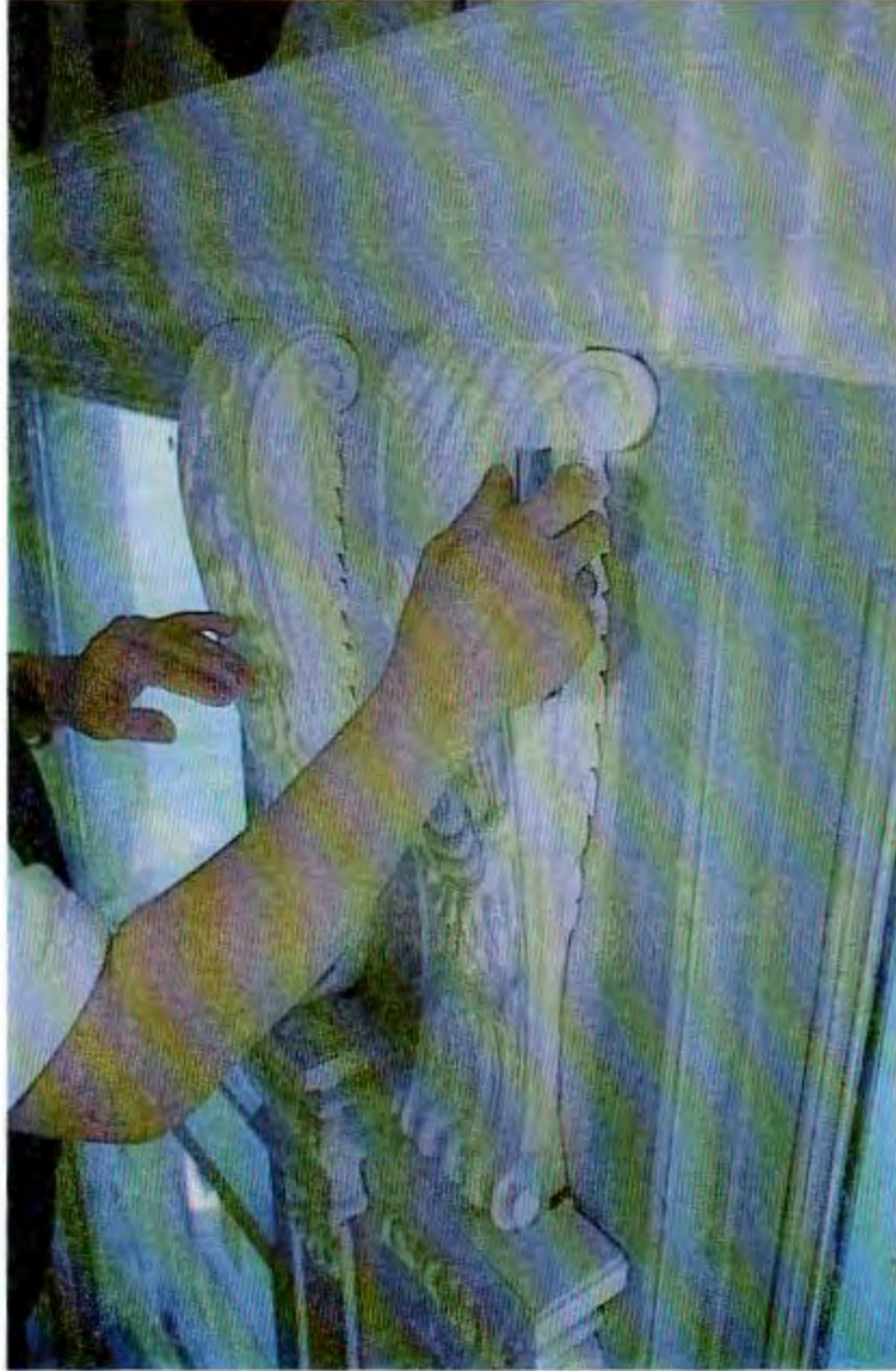
Bolonya alçısı ile kaplanan oymaların zımpara ile pürüzsüz hale getirilmesi.
