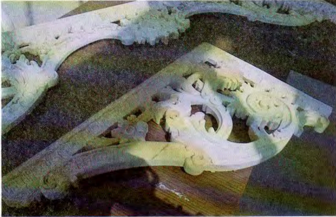
Asaf paşa yalısı, Deniz Köşkünü antik altın varak ile yapılan süslemelerinin, bolonya alçısı ile kaplanması
