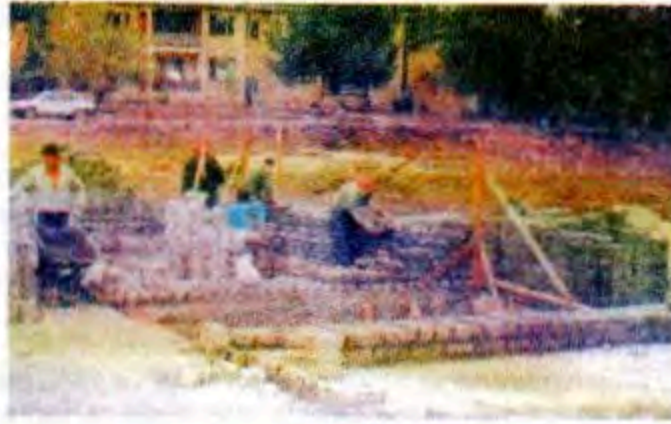
Resim 7.3. Beton Parke Taş Tesislerinde Üretilen Alker Bloklar ile Yığma Duvar Örülmesi
