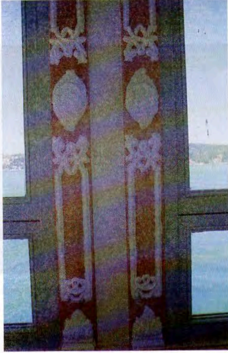
Bolonya alçısı ile ahşapın üzeri kaplanıyor.
