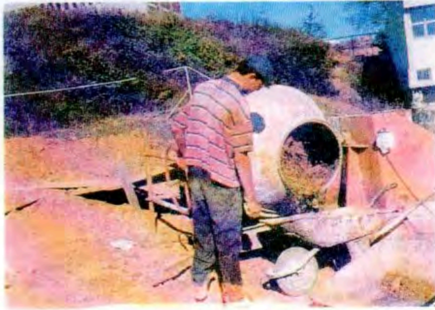
Resim 5.3. Alker Malzemesinin Betoniyerde Karıştırılışı.
