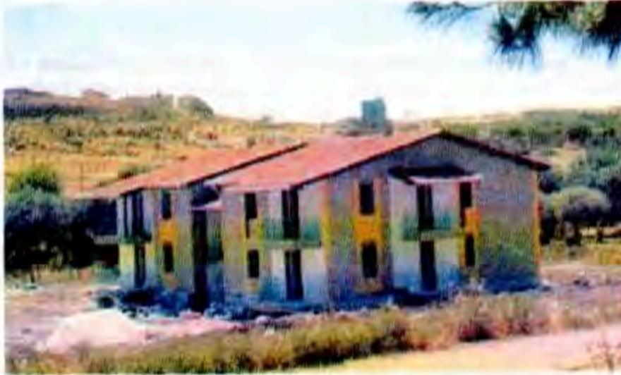
Resim 7. 1. İTÜ GAP Alker Pilot Yapısı'nın Haziran 2000 Görünüşü
